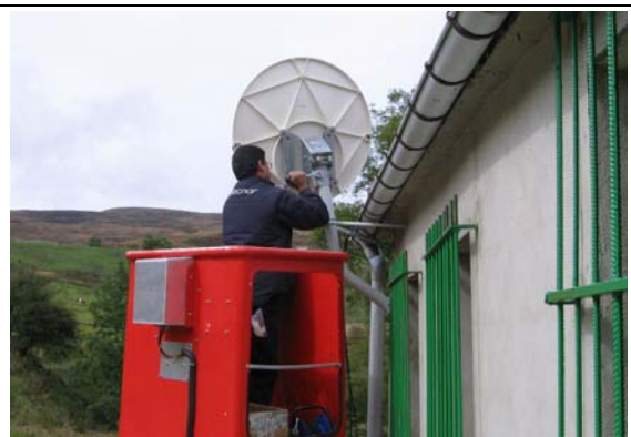
Instalando la antena en Trueba
