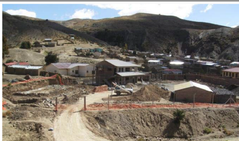
Morocomarca en Bolivia: construcción de internado
