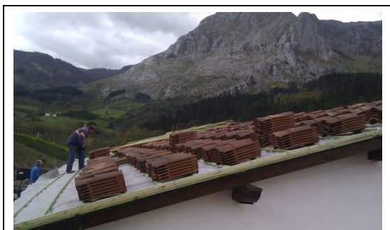
Retejado del caserío Lekun – etxea
