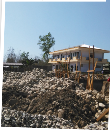
El Asrama en proceso de construcción
