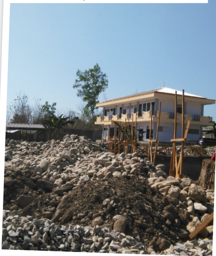
El Asrama en proceso de construcción
