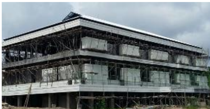
Las obras del internado, a mediados de enero.
