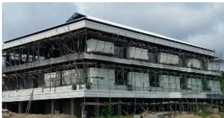
Les travaux de l'internat, à la mi-Janvier
