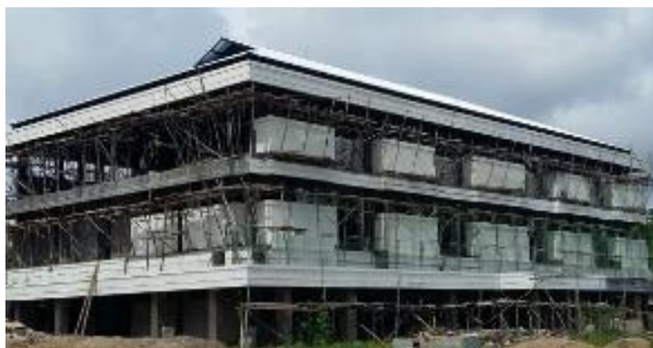
Lo stato dei lavori del convitto, a metà gennaio
