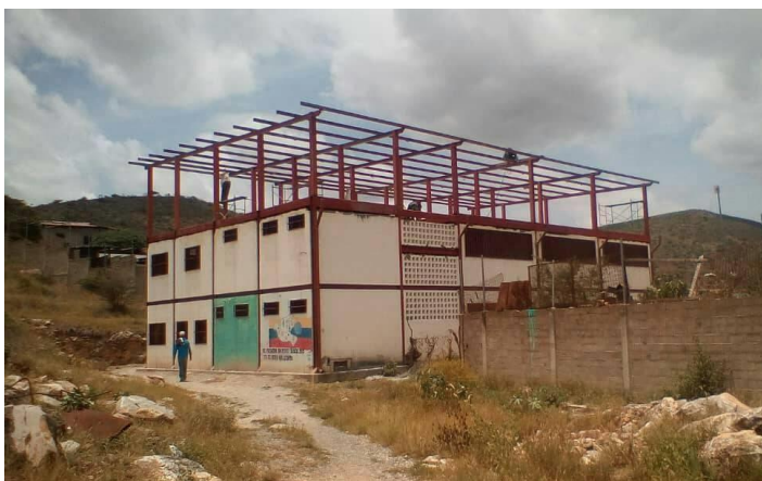
Vista del edificio del liceo, con las obras de ampliación en marcha.
