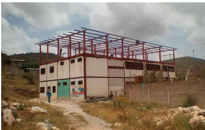
Vue du bâtiment du lycée, travaux d'agrandissement en cours.
