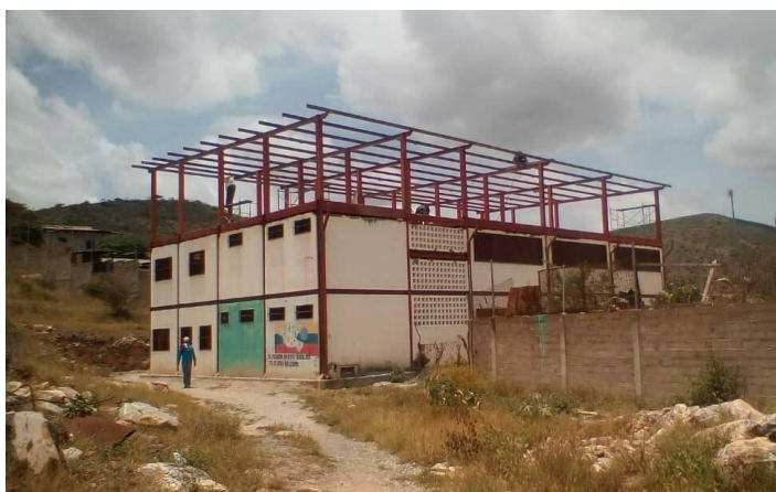
Vista do prédio do liceu, com as obras da ampliação.
